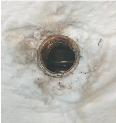
Abb. 3: Einfüllstutzen mit Glyzerin max. Füllstand
